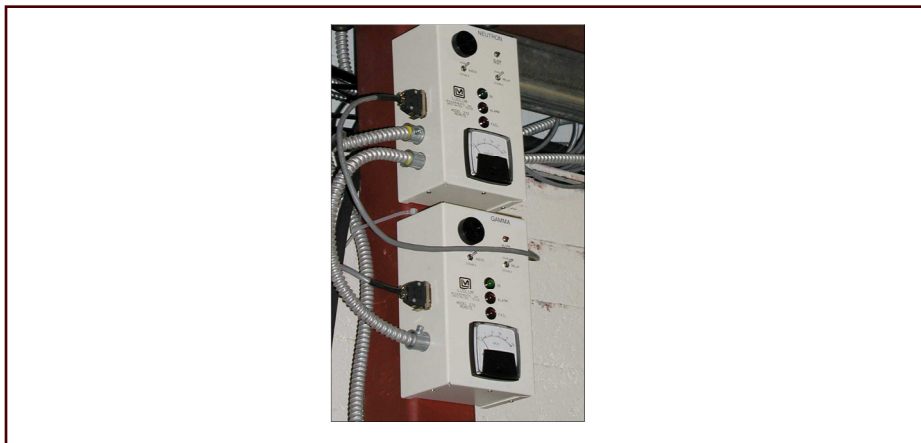
شکل ۷۷- قفل داخلی در اتاق پرتونگاری صنعتی
