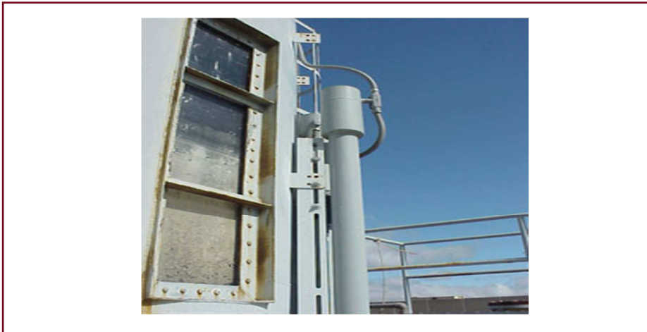
شکل ۱۷- چشمه نقطه ای - آشکارساز میله ای: برای اندازه گیری پیوسته سطح
